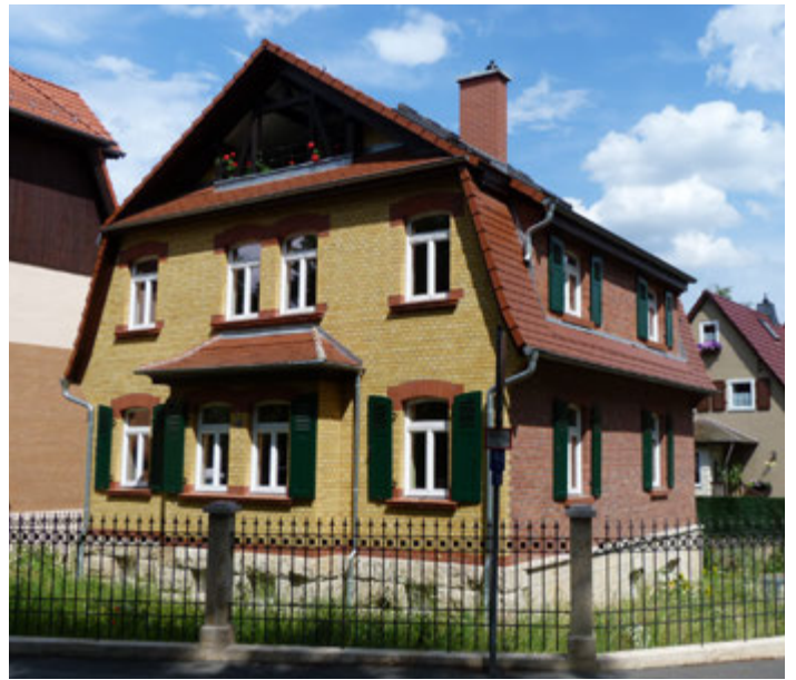
Fassadenansicht Wenigenjenaer Ufer 12
