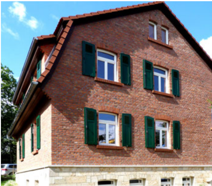
Rückansicht Wenigenjenaer Ufer 12
