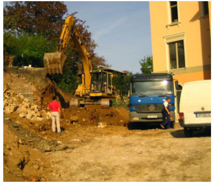
Während der Bauarbeiten
