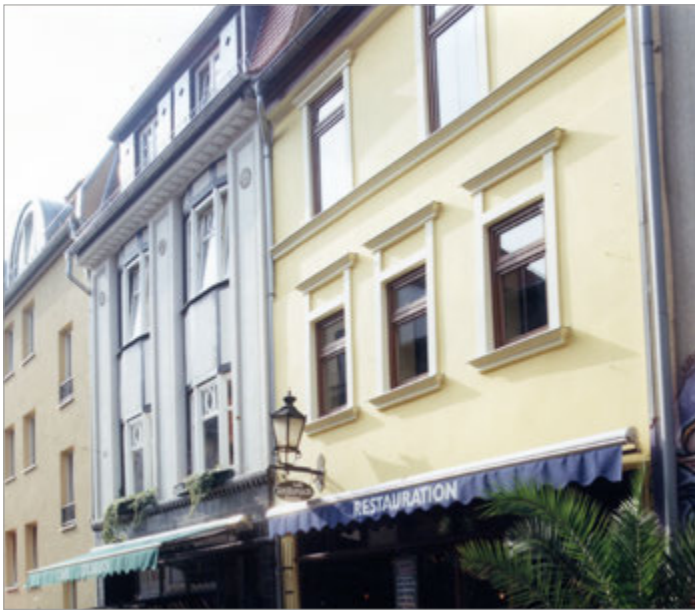
Fassaden mit Gaslaterne
