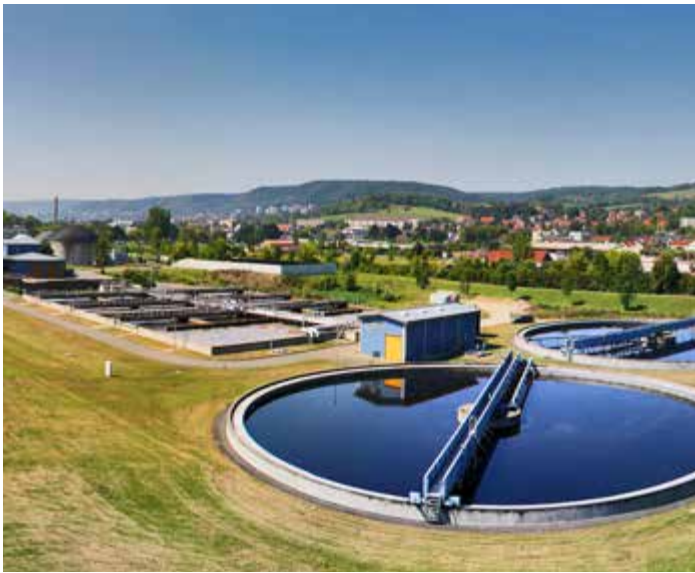
Energieautarke Kläranlage Jena
