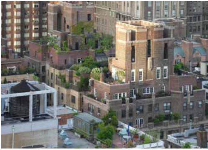
Wohnlich gestaltete Dachterrassen in Midtown Manhattan
