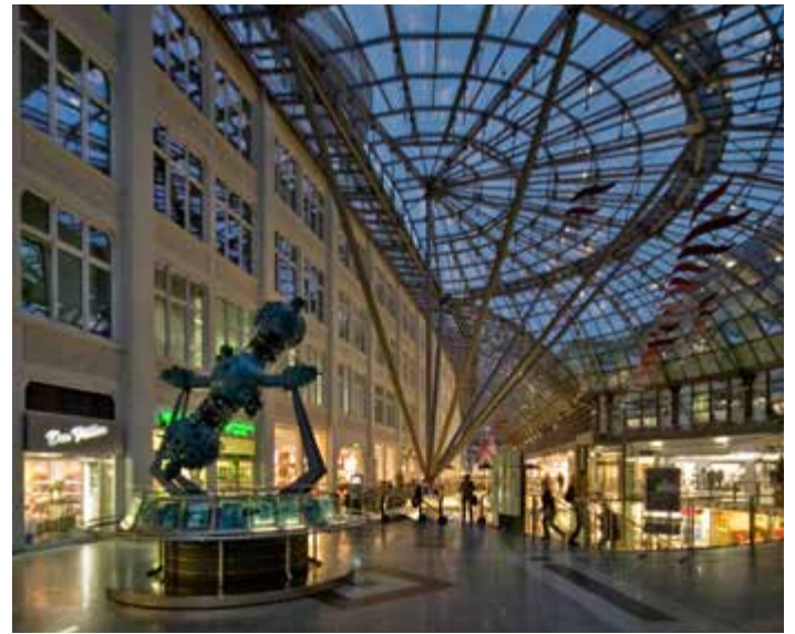
Zum Einkaufszentrum Goethe Galerie umgebaute ehemalige Werkstraße des Zeiss-Hauptwerkes
