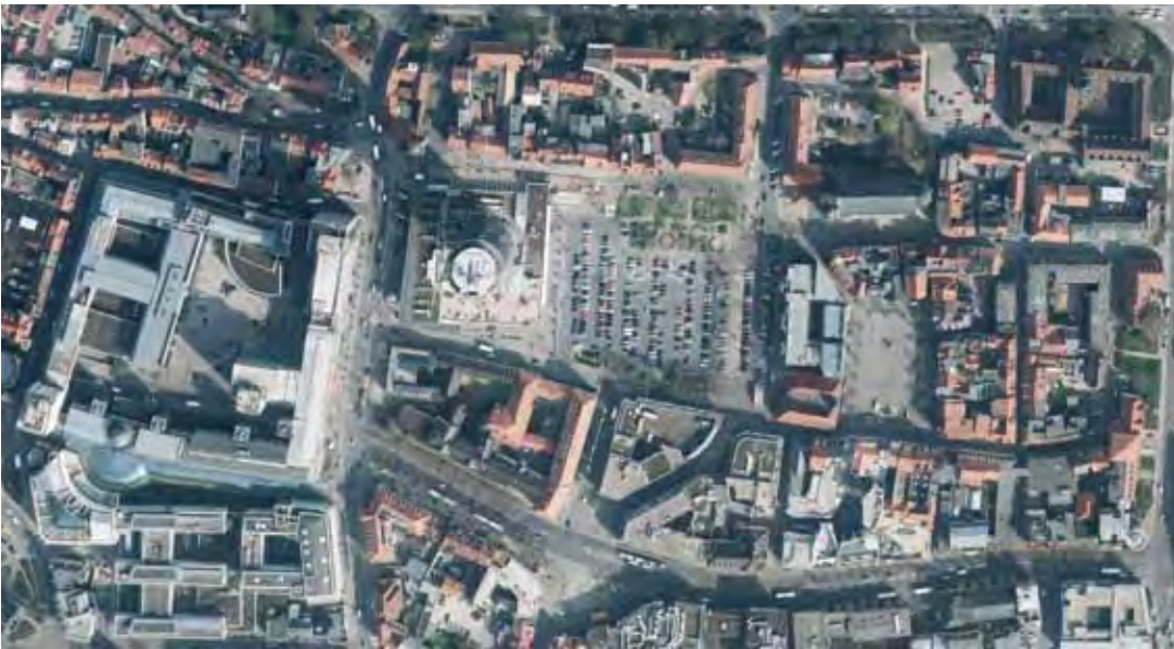
Erweiterter Untersuchungsraum – der Stadtkern von Jena (Luftbild 2014, Quelle: GeoBasisDE/TLVermGeo)
