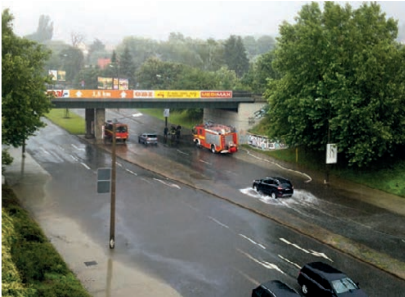
Abbildung 5.6: Überschwemmung einer Straßensenke in der Lößstedter Straße nach einem Regenereignis am 17. Juli 2012 (Quelle: Lerm)
